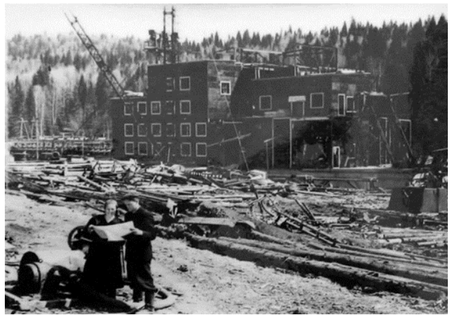
Строительство драги № 148 в устье р. Койвы. Начало 1950-х годов
