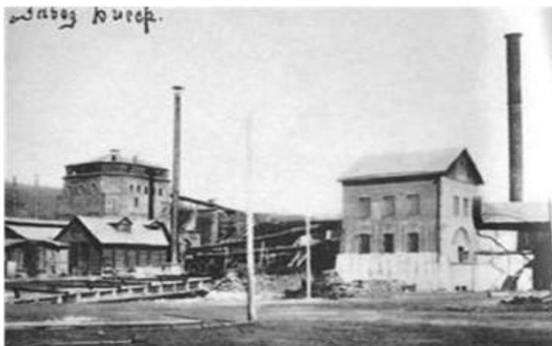
Старинные здания цехов Бисерского завода
