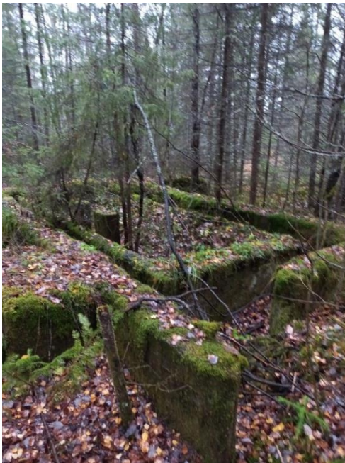
Фундамент обогатительной фабрики № 17
