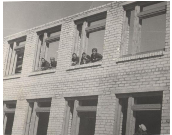
Строительство школы № 8 г. Красновишерск Первая справа – Зотова Нэлли Павловна
