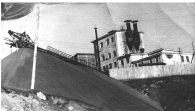
Доводочная фабрика п. Кусье-Александровский
