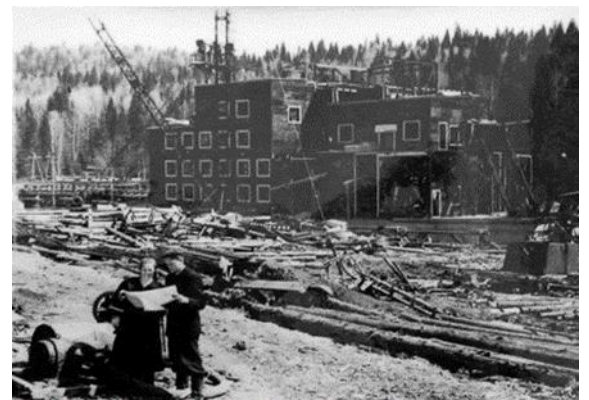
Строительство драги № 148 в устье р. Койва. Начало 1950-х годов
